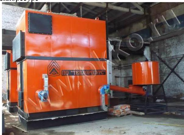
Топливом для котлов КМТ могут служить: отходы древесины — щепы, кора, опилки и стружки; торф кусковой, фрезерный и гранулированный; топливные брикеты и гранулы
